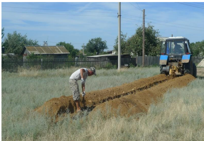
Строительство газопровода в х.Сафронов Захаровского сельского поселения
